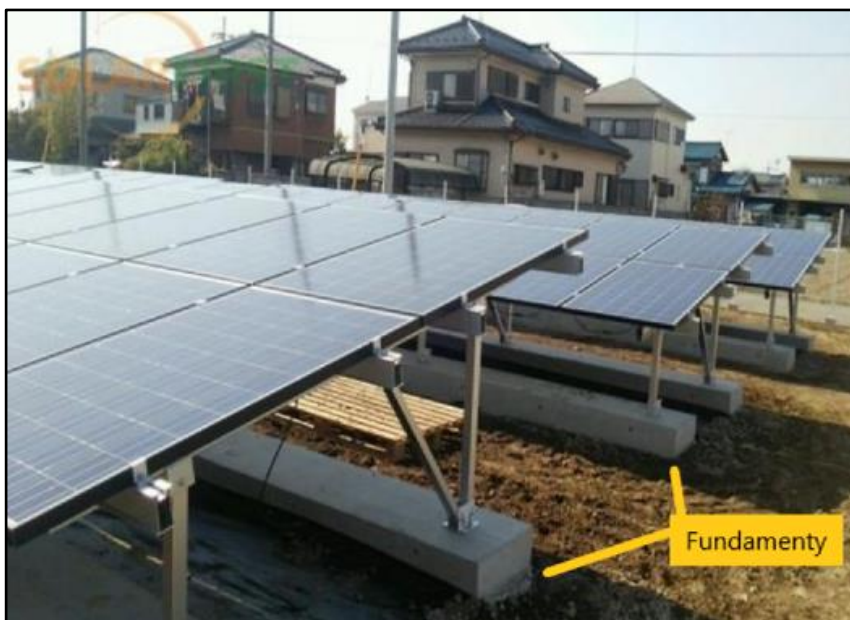
Ryc. 16 Montaż paneli - prefabrykowane fundamenty. Źródło: Google grafika
