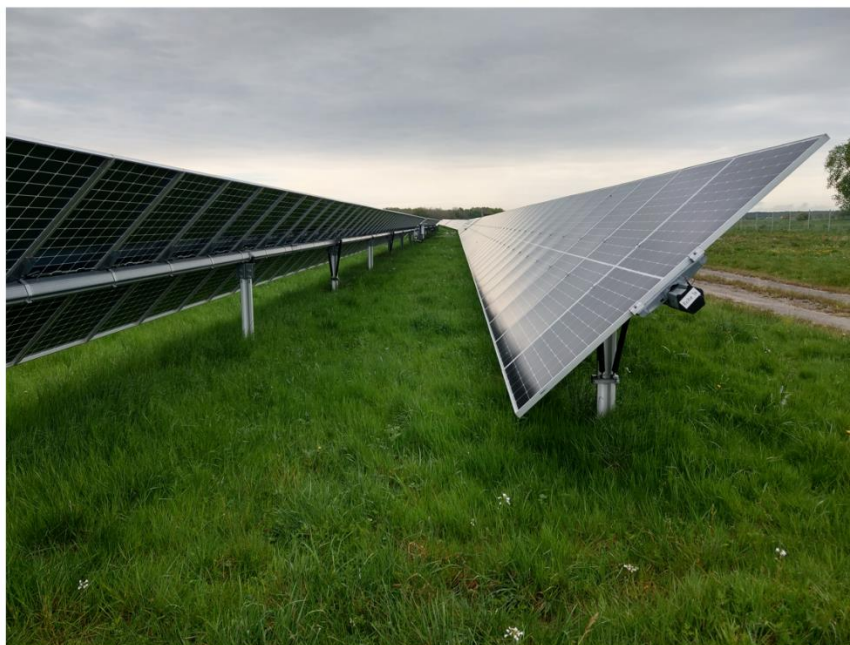
Ryc. 15 Montaż systemu nadążnego - wbicie w grunt Źródło: Google grafika
