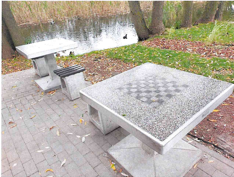
Zdjęcie nr 71. Stoły szachowe z siedziskami. Nieprawidłowy montaż stołu względem siedzisk.
