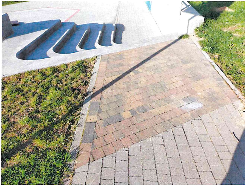
Zdjęcie nr 3. Nawierzchnia z kostki betonowej w kolorze szarym i czerwonym, bezfazowa.
