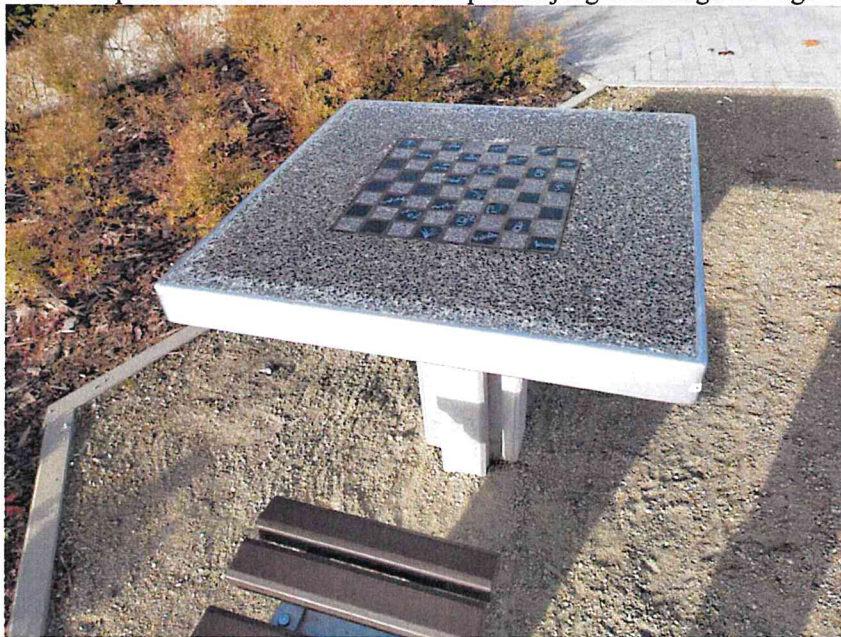
Zdjęcie nr 21. Akt wandalizmu, nieprawidłowy montaż stołu względem siedzisk.
