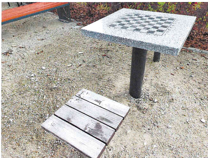
Zdjęcie nr 63. Stół szachowy z dwoma siedziskami, ubytki impregnatu na siedziskach.
