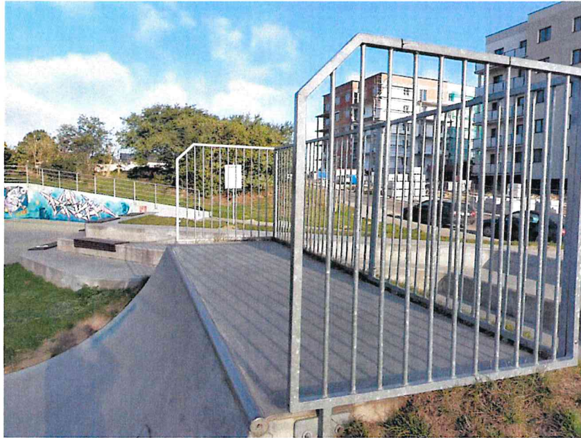
Zdjęcie nr 7. Tor skate parku z barierką ze stali ocynkowanej ognio, coping z rury stalowej ocynkowanej zaślepijony stalowymi zaślepkami.
