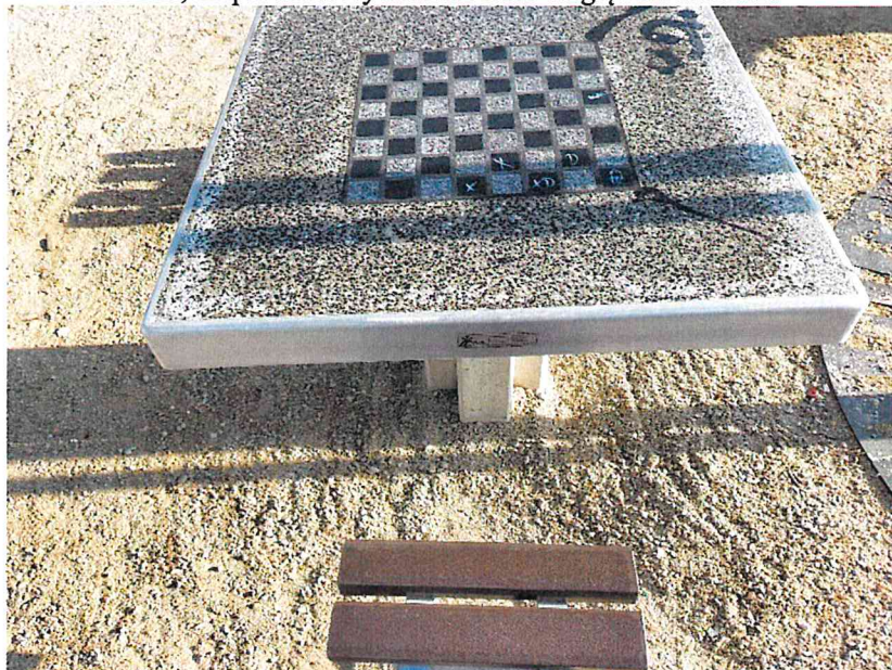
Zdjęcie nr 22. Akt wandalizmu, nieprawidłowy montaż stołu względem siedzisk.
