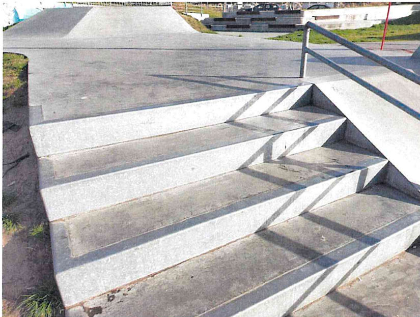
Zdjęcie nr 11. Schody z elementami stalowymi, stal ocynkowana ogniowo, zaokrąglona na krawędziach.
