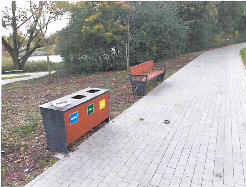
Zdjęcie nr 43. Chodnik z kostki betonowej szarej, kosze na segregację odpadów.
