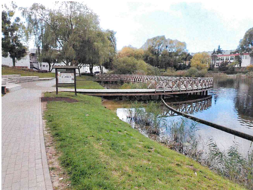
Zdjęcie nr 52. Pomost na 2 z poszyciem z bali drewnianych.
