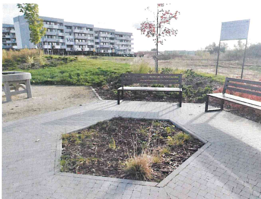
Zdjęcie nr 23. Ławki z oparciem, nawierzchnia z kostki betonowej szarej, nawierzchnia z kruszywa mineralnego, stół do piłkarzyków, tablica pamiątkowa Projektu.
