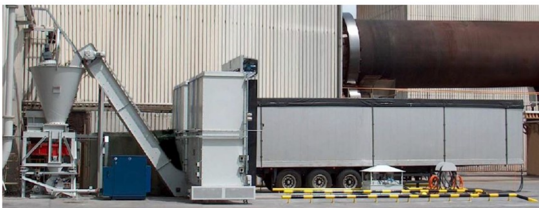
Rys. nr 3.2-3 Zrealizowany węzeł rozładunkowy (materiał firmy WTW – Engineering)
