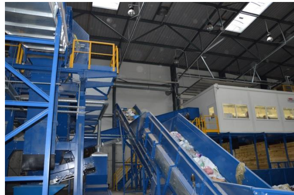
Rysunek 10 Tak jest. Nowa sortownia odpadów (komunalnych zmieszanych i surowcowych), Sulńówko (foto: Sulńówko, wrzesień 2015r).
