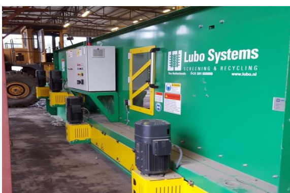
Rysunek 35 Tak jest. Sortownia w Lipnie w trakcie modernizacji (foto: Lipno, październik 2015r).
