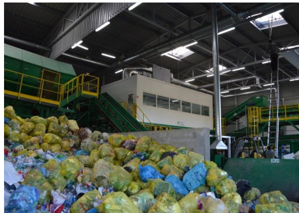
Rysunek 2 Tak jest. Nowa sortownia odpadów komunalnych (zmieszanych i surowcowych), Bładowo (foto: Bładowo, październik 2015r).
