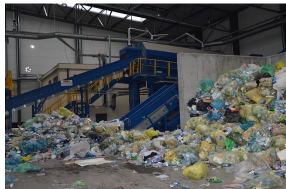
Rysunek 8 Tak jest. Nowa sortownia odpadów (komunalnych zmieszanych i surowcowych), Sulńówko (foto: Sulńówko, wrzesień 2015r).
