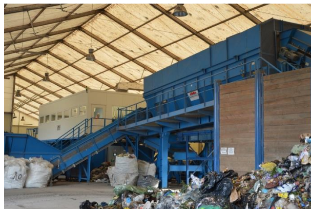
Rysunek 20 Tak jest. Sortownia odpadów (komunalnych zmieszanych i surowcowych), Osnowo (foto: Osnowo, wrzesień 2015r).
