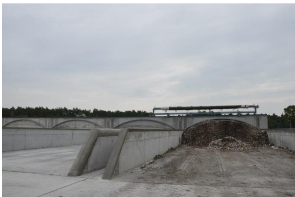
Rysunek 37 Tak jest. Nowa instalacja do biologicznego przetwarzania odpadów z możliwością kompostowania odpadów zielonych, Lipno (foto: Lipno, wrzesień 2015r).
