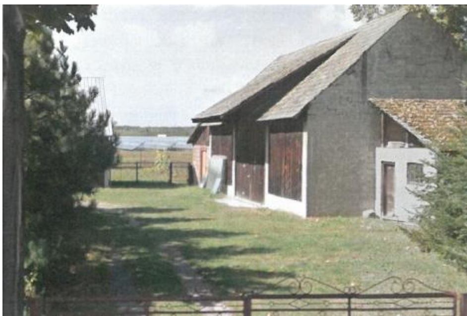
Zdjęcie 2 Widok na instalację fotowoltaiczną z odległości ok. 140 m.
