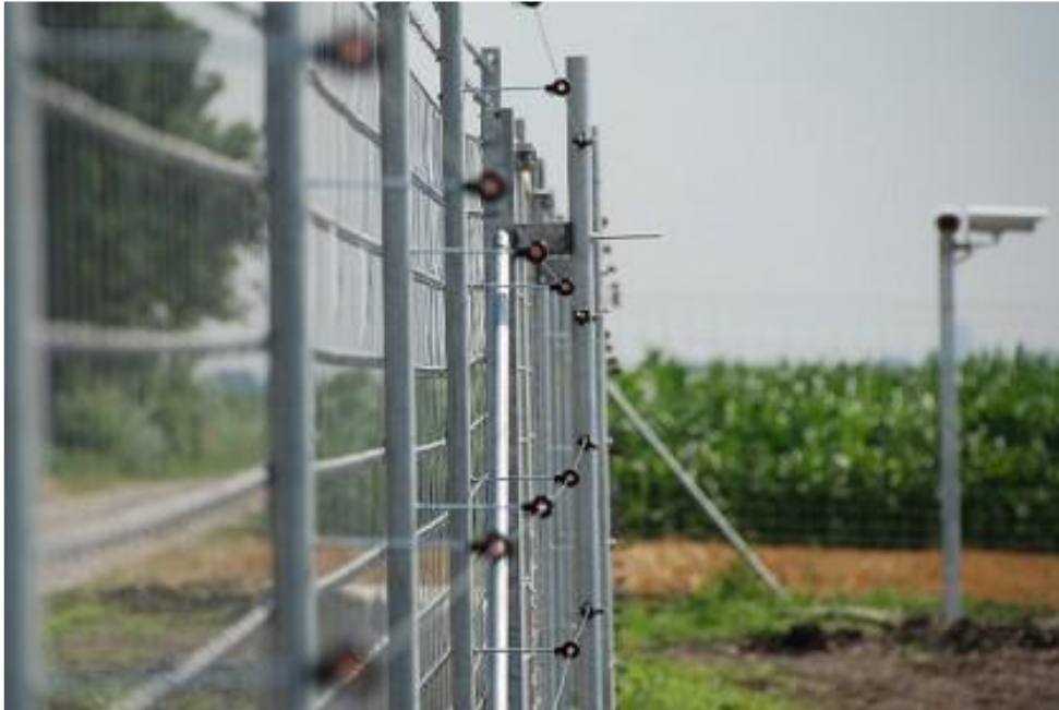
Rysunek 3 Przykładowe ogrodzenie farmy fotowoltaicznej
