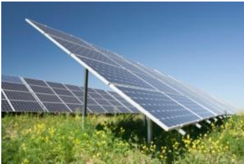
Rysunek 4 Sposób montażu paneli fotowoltaicznych na stelażach wbijanych bezpośrednio do gruntu.
