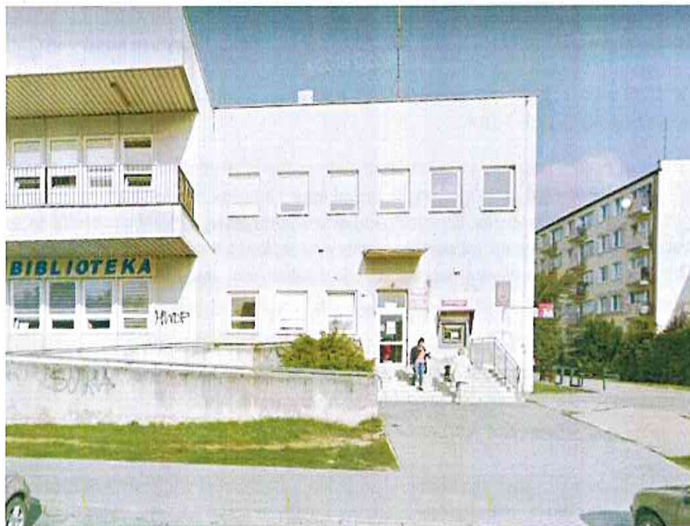
Fotografia 1. Budynek przy ul. Wyszyńskiego 15 w Świeciu
