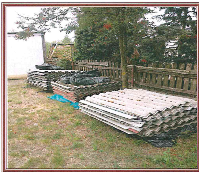
Rys. 11. Azbest pochodzący z budynku gospodarczego zlokalizowanego w m. Czaple, przygotowywany do zabezpieczenia i utylizacji (źródło: Urząd Miejski w Świeciu).
