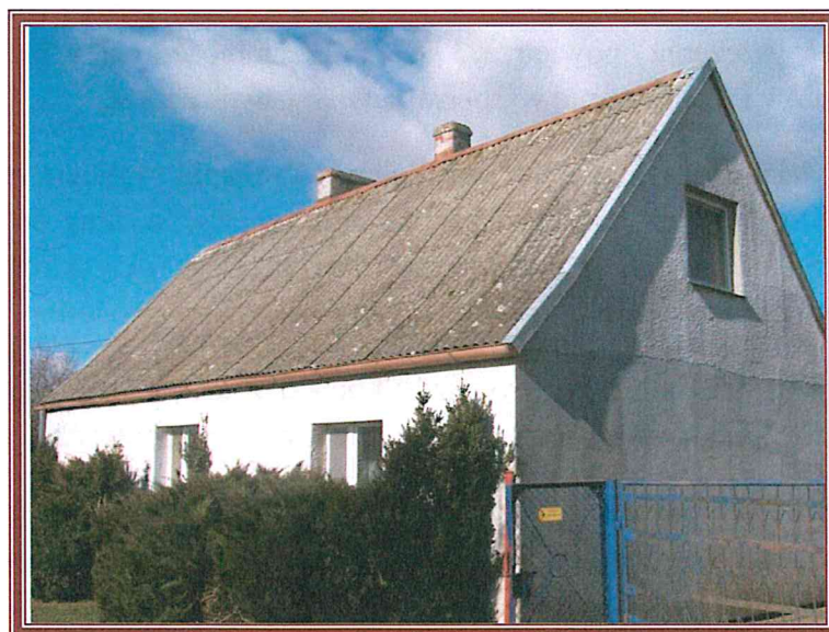
Rys. 3. Budynek mieszkalny pokryty płytą falistą azbestowo-cementową zlokalizowany w Gminie Świecie (źródło: własne).
