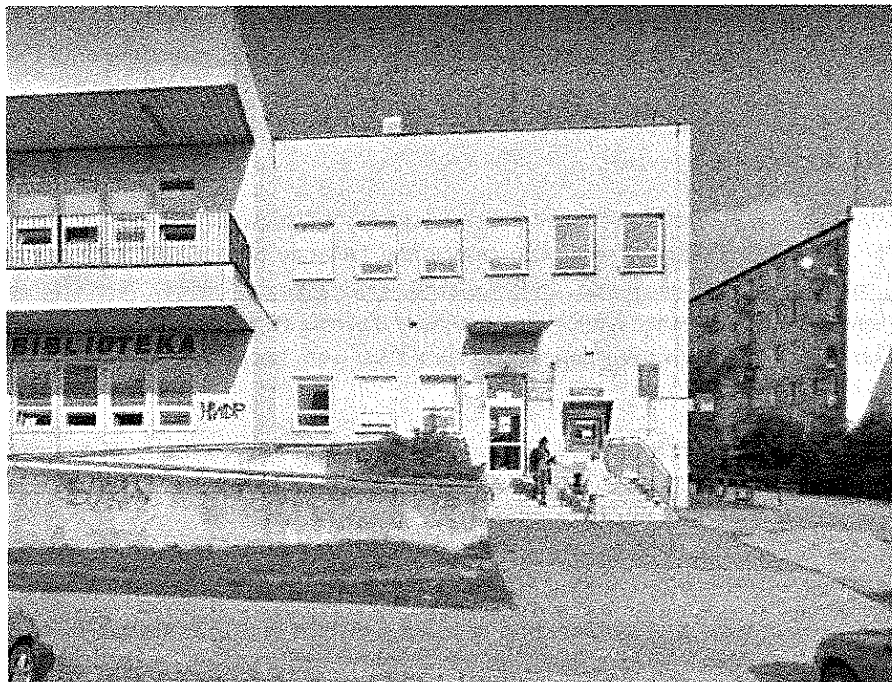
Fotografia 1. Budynek przy ul. Wyszyńskiego 15 w Świeciu
