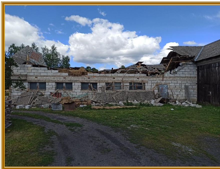
Rys. 8. Budynek gospodarczy przeznaczony do rozbiórki pokryty płytą falistą azbestowo-cementową zlokalizowany w Gminie Świecie (źródło: własne).
