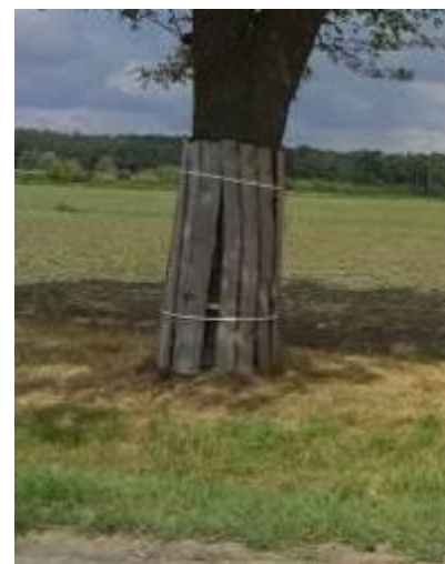
Przykładowy sposób ochrony pnia drzewa przed uszkodzeniami mechanicznymi
