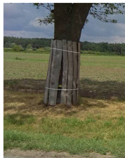
Fotografia 1 Przykładowy sposób ochrony pnia drzewa przed uszkodzeniami mechanicznymi
