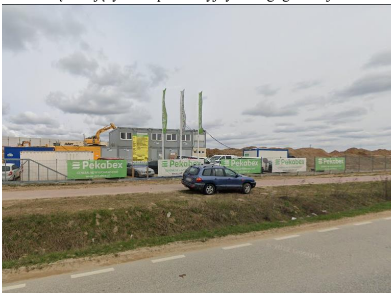
Fotografia nr 3. Widok na sąsiadujący teren produkcyjny z drogi gminnej.
