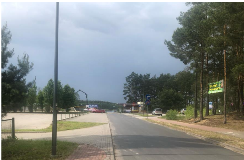
Fotografia nr 1. Widok na teren nr 1UT/UG nad Jezioro Deczno.
