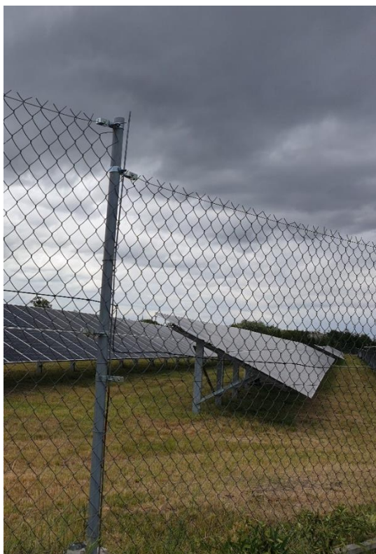
Fot. 2. Sposób montażu paneli fotowoltaicznych na stelażach wbijanych bezpośrednio do gruntu.
