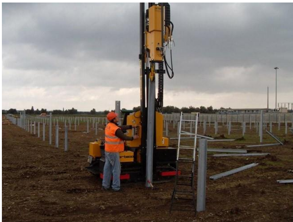
Fot. 4. Montaż profili za pomocą kofara ( http://www.liftonpolska.pl/ ).
