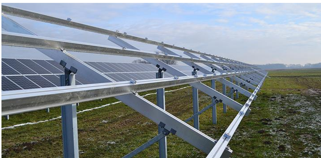
Fot. 5. Przykładowa konstrukcja przeznaczona do posadowienia paneli fotowoltaicznych ( http://www.planergia.pl/ ).
