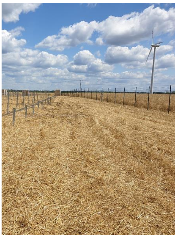
Fot. 1. Przykładowe ogrodzenie farmy fotowoltaicznej.
