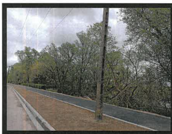
Odcinek ul. Wodnej wzdłuż rzeki Wdy, po remoncie w 2023 r.
