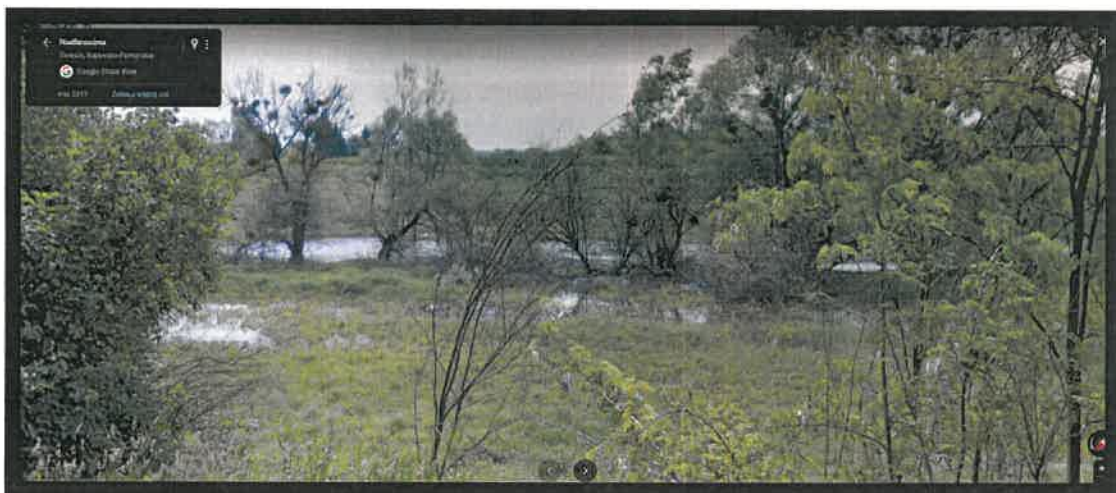
Cykliczne, coroczne podtopienia terenu między rzeką Wdą a ul. Nadbrzeżną. (geoportal)
