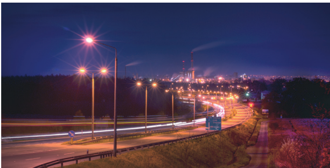
Zdj. 10. Obwodnica; źródło: Urząd Miejski na potrzeby promocji
